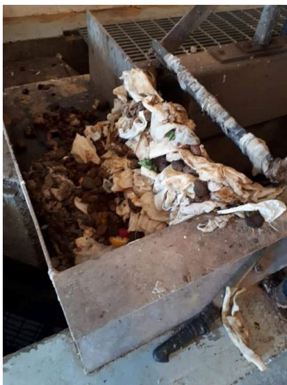
Figure 1 – Dégrilleur rempli de lingettes et autres déchets
