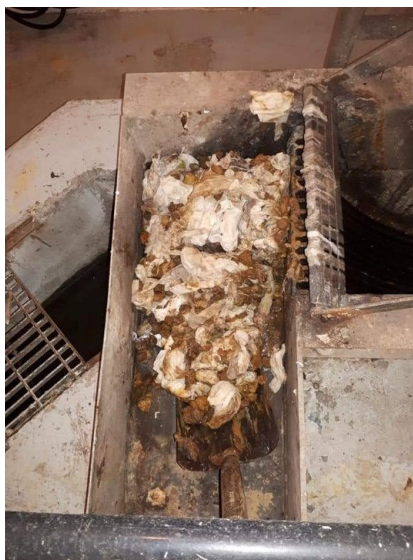
Figure 2 - Dégrilleur rempli de lingettes et autres déchets
