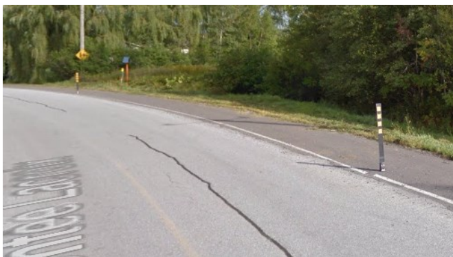
ACCOTEMENT SUR LA MONTÉE LACROIX, ENTRE LES RUES ST-CHARLES ET ST-JEAN
