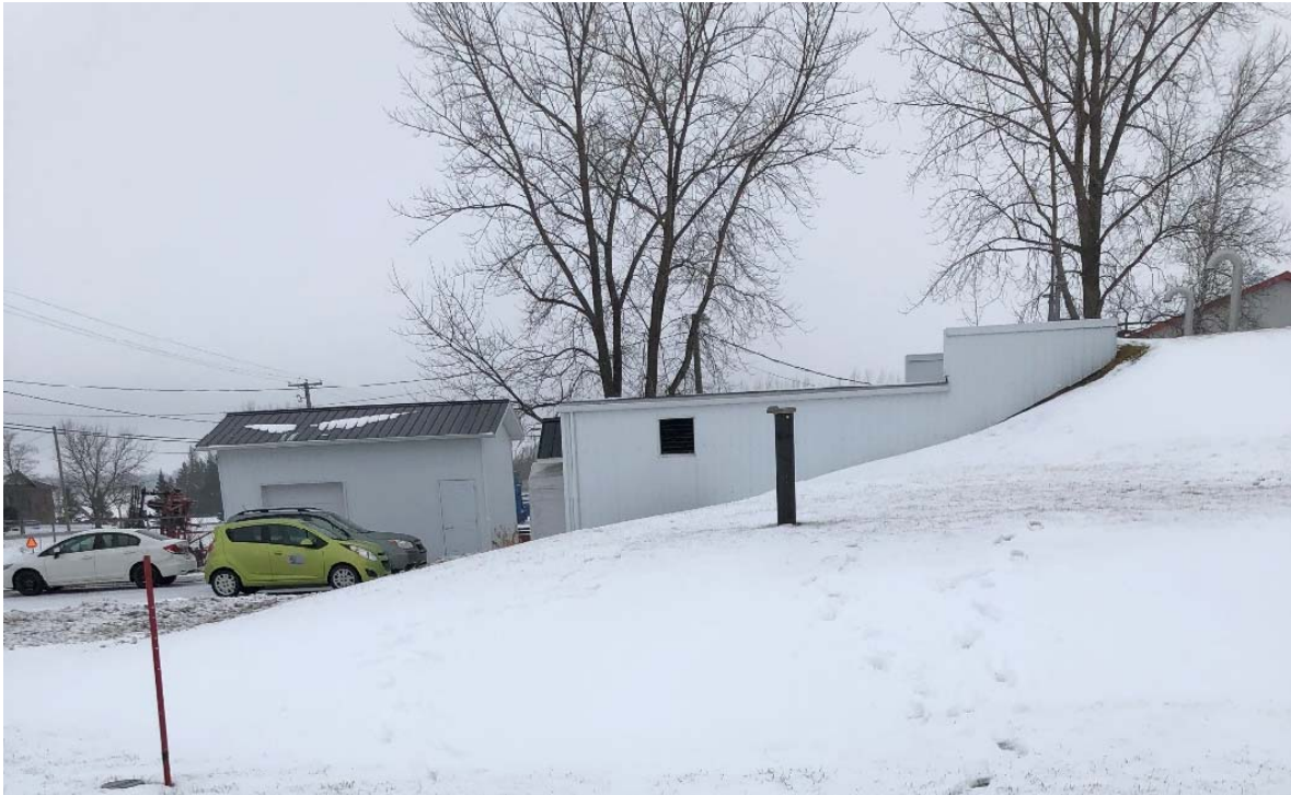
Photo 3 Puits PE-02 (18 janvier 2023)
