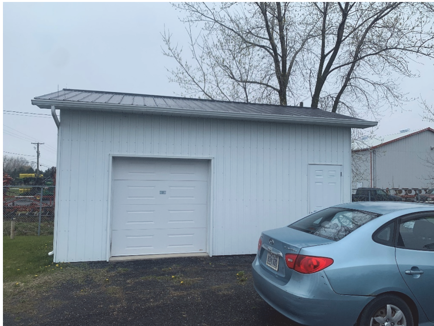
16. Vue du bâtiment logeant la génératrice et les produits de traitement – 2024-05-02
