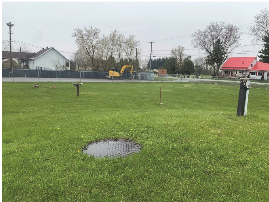
2. Vue des trois puits du secteur de la Grande-Ligne – 2024-05-02
