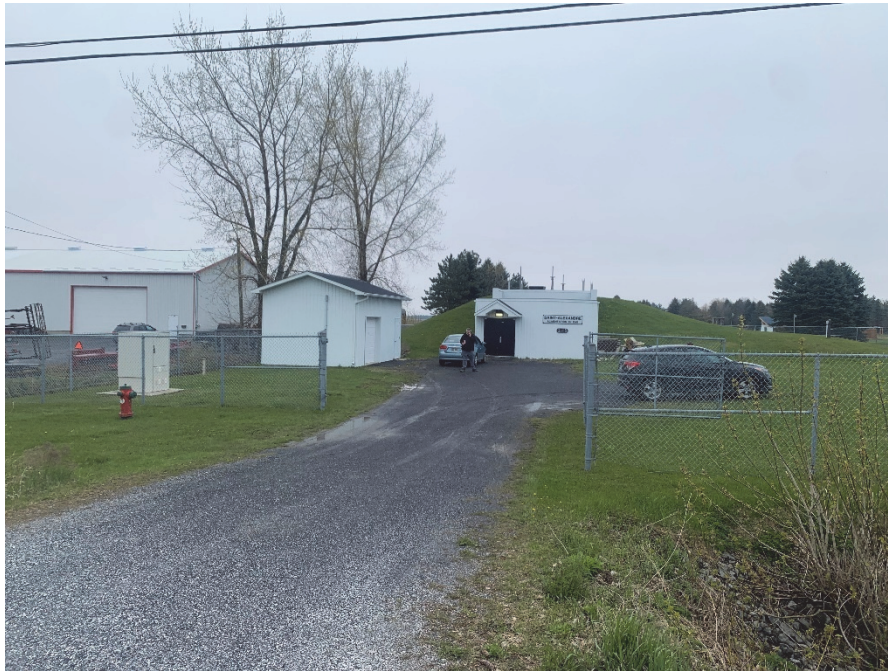
1. Accès aux puits du secteur de la Grande-Ligne et à l'installation de production – 2024-05-02
