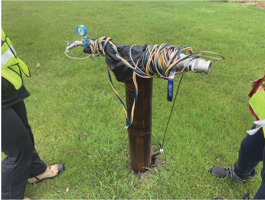
5. Vue du puits STA-21 (futur PE-04) – 2024-05-02
