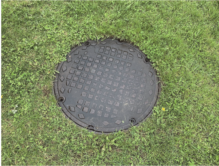
3. Vue du regard donnant accès au puits PE-01 – 2024-05-02
