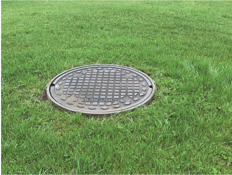
23. Vue du regard donnant accès au puits PE-03 – 2024-05-02
